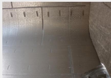
Футеровка ковша экскаватора из АСП
