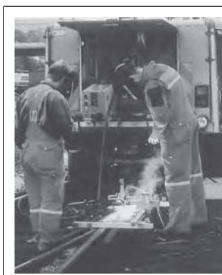
Механизированная наплавка рельсов и
