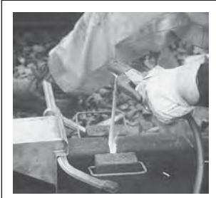
Сварка стыков рельсов электродами
