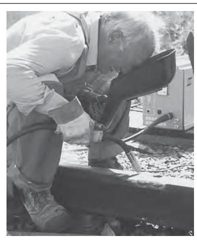
Наплавка головки рельса проволокой
