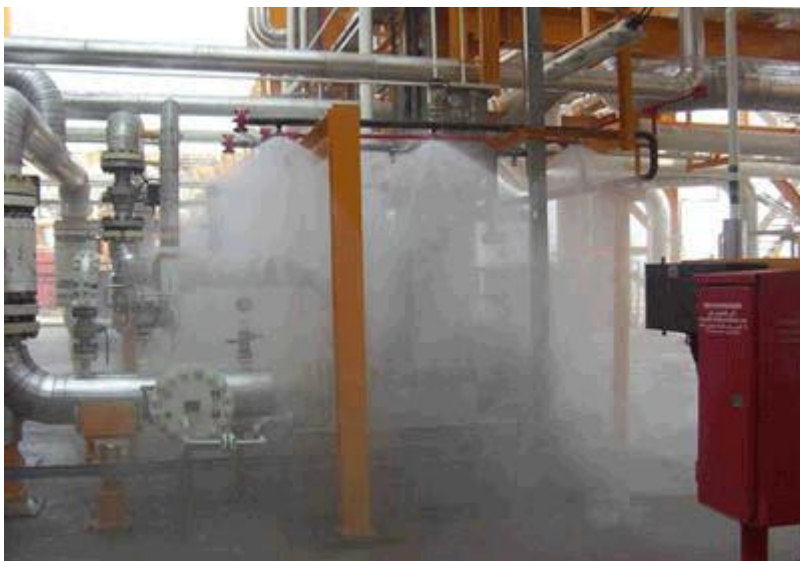
Пример системы водяного пожаротушения
