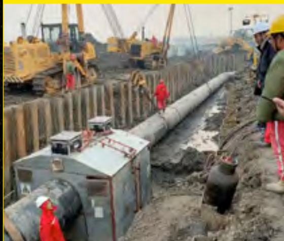
СВАРНОЙ ШОВ НА ВРЕЗКЕ
