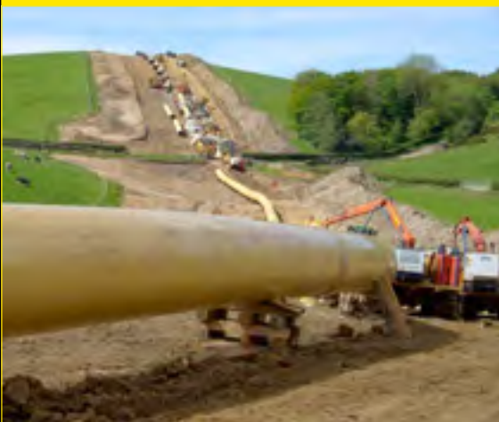
СВАРНОЙ ШОВ НА МАГИСТРАЛИ
