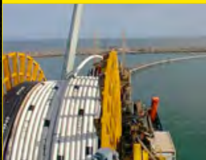
УКЛАДКА С БАРАБАНА (БЕРЕГОВАЯ)
