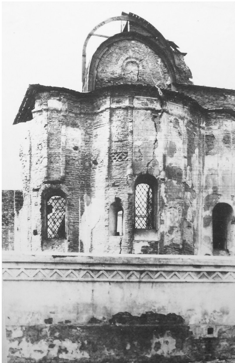
Рис. 1. Східний фасад П'ятницької церкви. Фото 1953 р.
