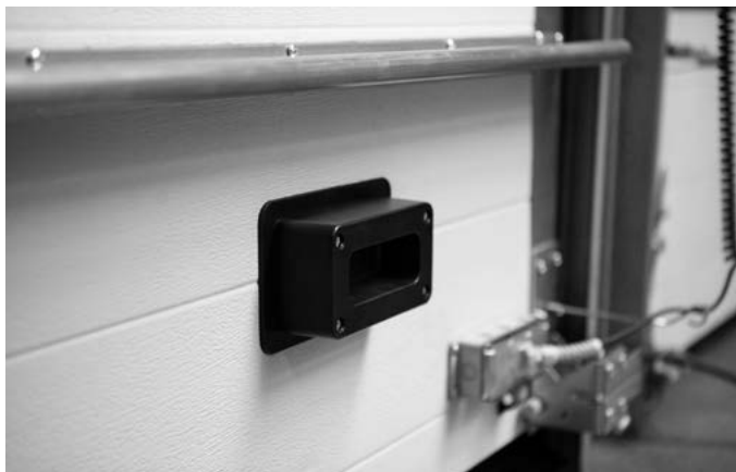
Рис. 43. Рукоятка для ручного подъёма – вид с внутренней стороны.
