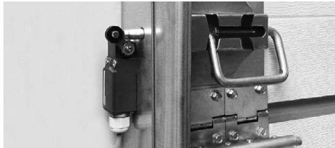
Рис. 32. Пример монтажа датчика открытия замка/ручного засова.
