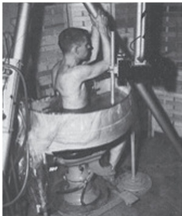
Рис. 1.2. Ультразвуковой аппарат на основе иммерсионной ванны, 1950-е гг. (из Hagen-Ansert S.L. Textbook of Diagnostic Sonography . 7th ed. St. Louis: Mosby, 2011)
