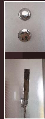
**Использование смесителя.** Поднимите ручку крана смесителя холодной и горячей воды вверх. Поворот ручки крана по часовой стрелке открывает горячую воду, против часовой стрелки – холодную. Отрегулируйте положение ручки так, чтобы, смешившись, холодная и горячая вода дали нужную температуру. При открытом кране смесителя холодной и горячей воды поверните переключатель душевых устройств (верхнего душа, съемного душа и т.д.), выберите необходимое в данный момент устройство.
