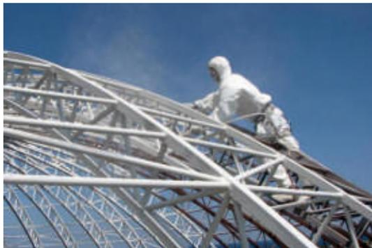
Краска **«ОГНЕЗА-ВД-М»** предназначена для защиты металлических конструкций от теплового воздействия огня. Огнезащитная эффективность обусловлена специально подобранной композицией, образующей после нанесения на поверхность металлоконструкций эластичную пленку, вспучивающуюся под воздействием высоких (выше 200 °С) температур и создающую устойчивый плотный теплоизолирующий слой пенококса.
