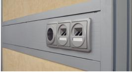
Электрокороб в средней части модуля (на высоте установки стола)
