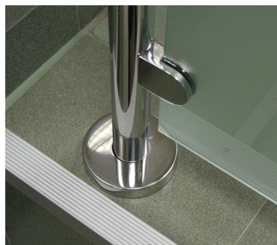
Угловое крепление имеет переходной элемент, который плотно входит в поручень образуя тонкий видимый стык. Крепление поручня вставляется в стойку и распирается. Поручень крепится винтами к ложементу крепления.
