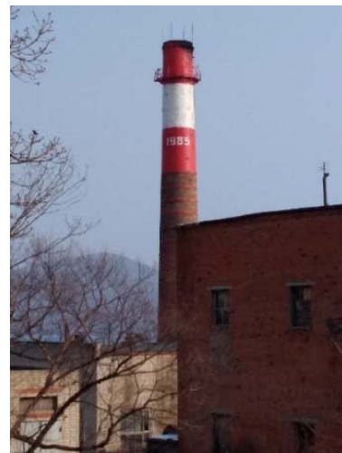
Котельная поселка Дунай
