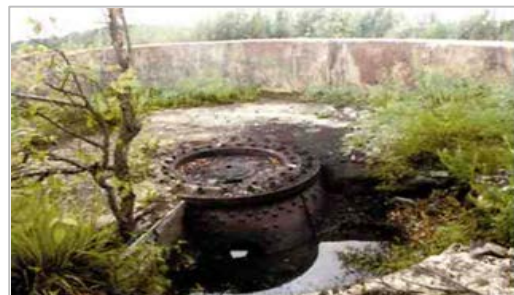
Шкотовский УР ТОФ. Береговая батарея № 940 на четыре 100-мм пушки Канэ с углом возвышения 40 градусов на мысе Трамбецкого. Орудийный дворик. Фото Ю.В. Иванова
