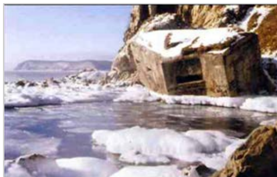
Шкотовский УР ТОФ. Трехамбразурный ДОТ (полукапонир) «Пляж» класса М-2 постройки 1939 г. Фото Ю.В. Иванова
