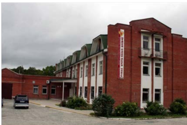
Новое здание МСЧ №100, в котором расположены администрация МСЧ, детская поликлиника, станция скорой помощи
