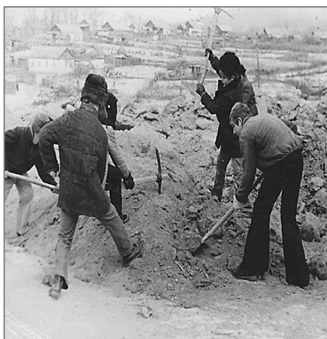
На строительстве школы, 1976 - 1978 годы
