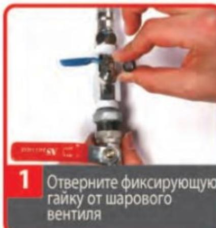
1 Отверните фиксирующую гайку от шарового вентиля
