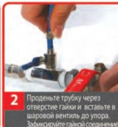
2 Проденьте трубку через отверстие гайки и вставьте в шаровой вентиль до упора. Зафиксируйте гайкой соединение.
