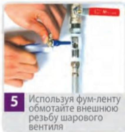
5 Используя фум-ленту обмотайте внешнюю резьбу шарового вентиля
