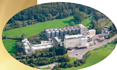
Солодовня Краймбах мощностью 55 000 тонн
