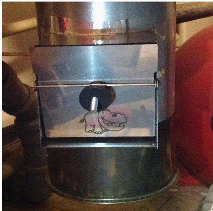
Стабилизатор тяги дымохода нужен для компенсации излишней тяги в дымоходе, которая может возникать при порывах ветра, чрезмерно высокой дымовой трубе.
