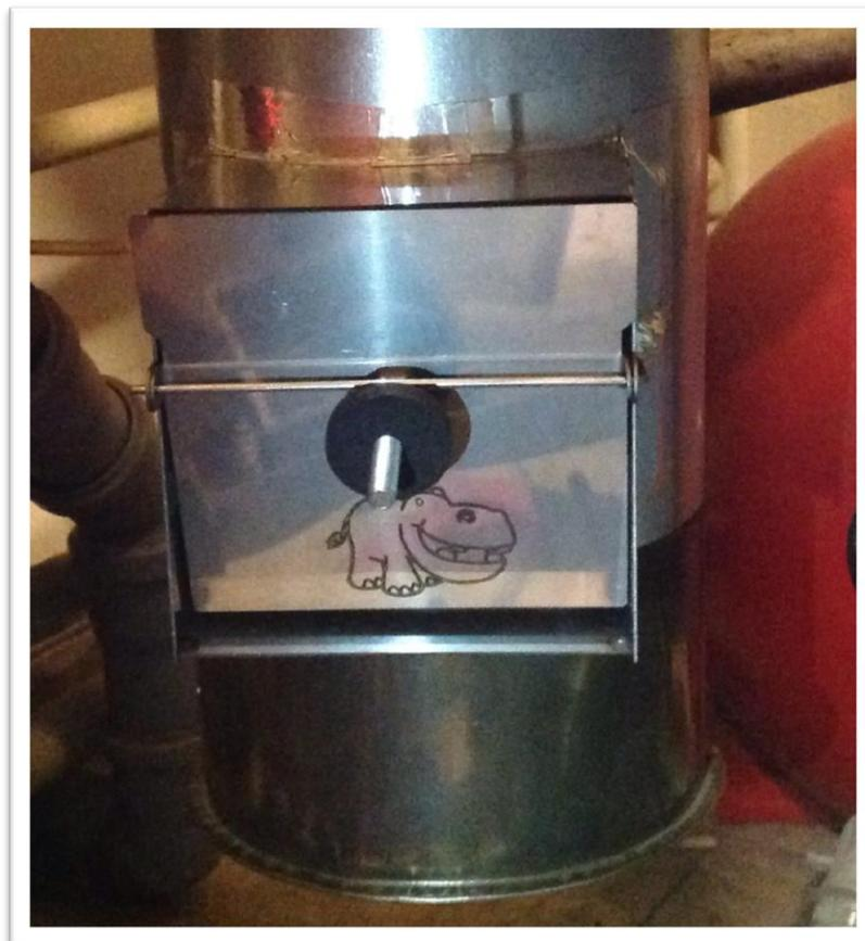
Стабилизатор тяги дымохода нужен для компенсации излишней тяги в дымоходе, которая может возникать при порывах ветра, чрезмерно высокой дымовой трубе.
