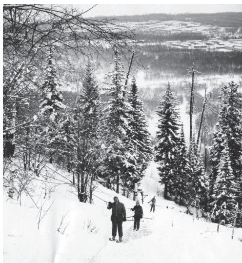
Вид с первой очереди подъёмника на Байкальск.
