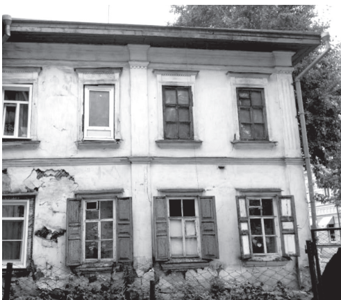
Рис. 24. Пример деревянного дома, в котором элементы фасадного декора выполнены штукатуркой по дранке (ул. Свердлова, 23. Фото М. Мееровича)
