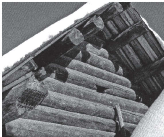
Рис. 12. Дом с самцовой кровлей. Архитектурно-этнографический музей «Тальцы». Источник: Калинина И. В., Красная Н. Н. Город и дерево. Архитектура и ремесло. — Иркутск: ООО Агентство «МайР», 2013. — 452 с., илл. С. 78
