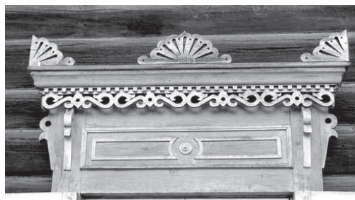
Рис. 44. Знаки прорастающих растений над знаком засеянного поля (ул. Грязнова, 9. Фото М. Мееровича)
