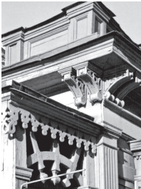
Рис. 29. Фальшивые деревянные кронштейны (ул. Декабрьских событий, 52). Источник: Калинина И. В., Красная Н. Н. Город и дерево. Архитектура и ремесло. — Иркутск: ООО Агентство «МайР», 2013. — 452 с., илл. С. 382.
