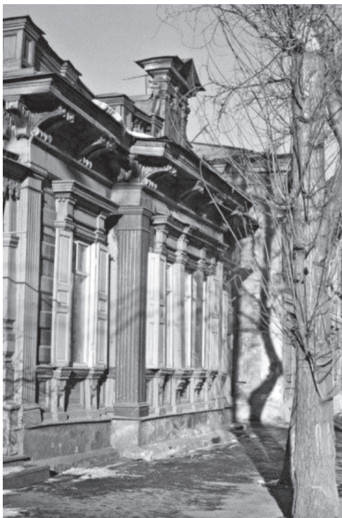
Рис. 27. Имитация форм каменной архитектуры в дереве (ул. Декабрьских Событий, 52). Источник: Калинина И. В., Красная Н. Н. Город и дерево. Архитектура и ремесло. — Иркутск: ООО Агентство «МайР», 2013. — 452 с., илл. С. 380.
