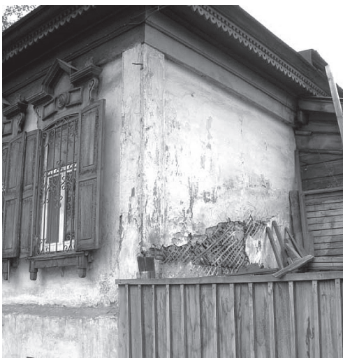
Рис. 25. Пример деревянного дома, оштукатуренного по дранке (ул. Некрасова, 9 а. Фото М. Мееровича)
