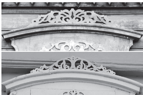
Рис. 58. Сплошная одноосевая композиция — лучковый карниз с единичным пропильным или скульптурным элементом (ул. Грязнова, 16 а, ул. Подгорная, 12. Фото А. Матвеевой)
