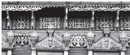
Рис. 62. Пример неатрибутированных форм декора иркутских деревянных зданий (ул. Иосифа Уткина, 6 б. Фото М. Мееровича)
