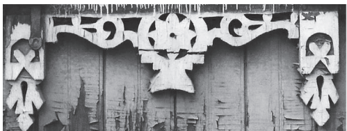
Рис. 61. Восточные элементы декора на подоконных досках (ул. Горького, 14. Фото А. Матвеевой)
