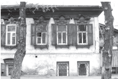
Рис. 26. Пример оштукатуренного деревянного дома с подшивным дощатым фризом, деревянными наличниками, ставнями, подкарнизным декором и проч. (ул. Некрасова, 9 а. Фото М. Мееровича)
