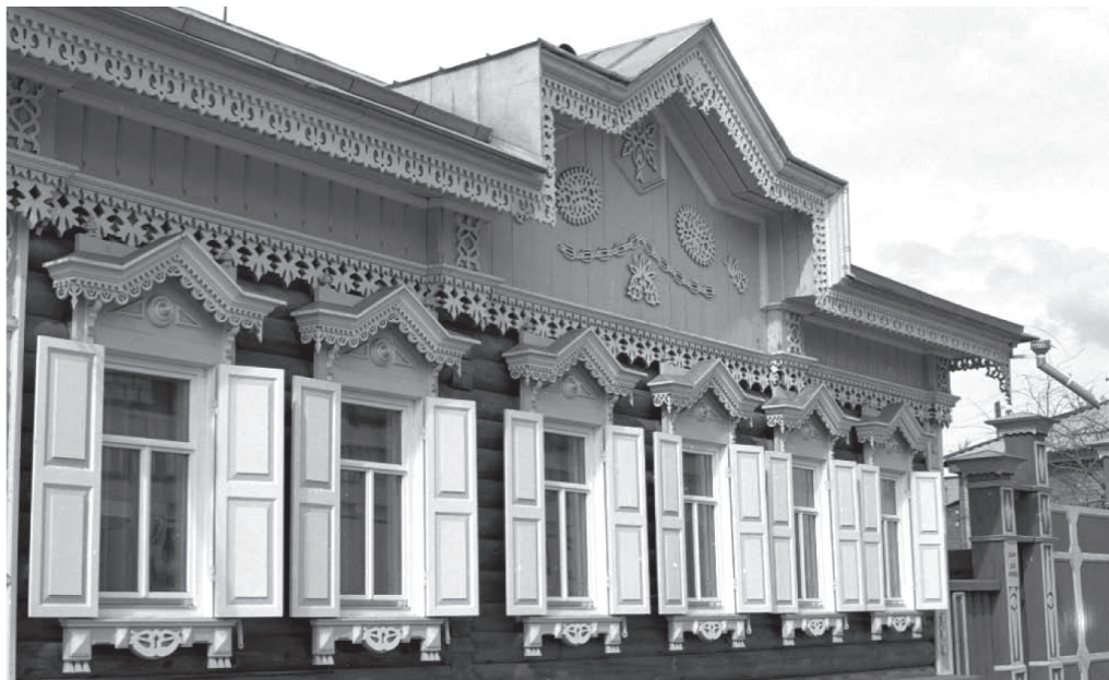
Рис. 14. Иркутск. Дом с вальмовой кровлей. Подкарнизный декор кровли и фронтона.
