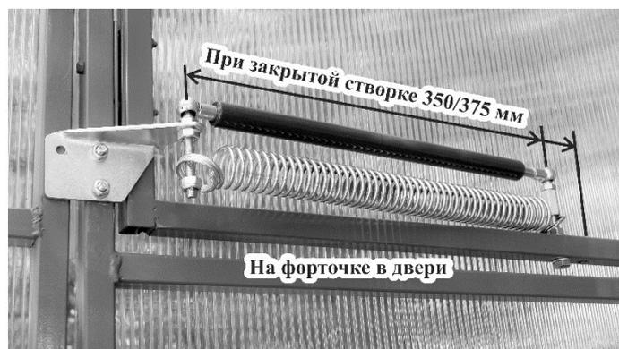
В зависимости от конструкции теплицы, установите шаровые опоры, обеспечив при закрытой створке расстояние между центрами опор 350 / 375 мм. Рычаг может быть установлен, как на конструкции теплицы, так и на створке.
