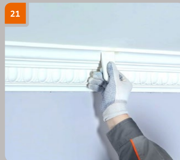
21 Мелкозернистой водорастворимой шпаклевкой для внутренних работ зашпаклевать обработанные стыки и места заглабления саморезов. После высыхания шпаклевки (60 минут) при необходимости повторить «Шаг 20».
