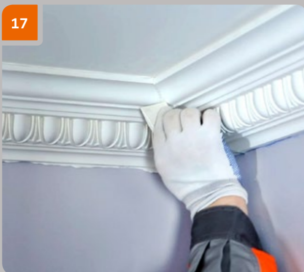
17 Сразу после приклеивания удалить выступившие излишки клея шпателем.
