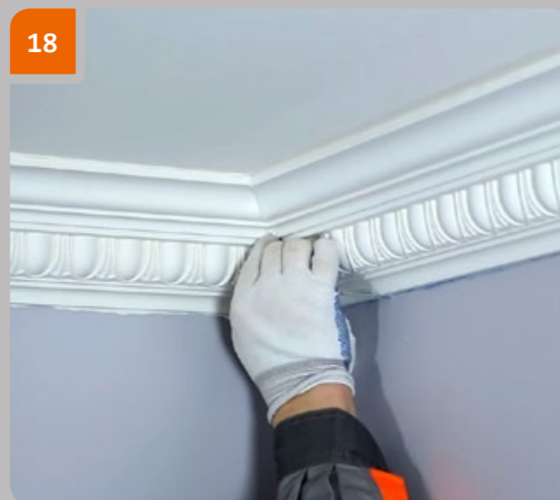
18 Протереть стык тканью, смоченной ацетоном.
