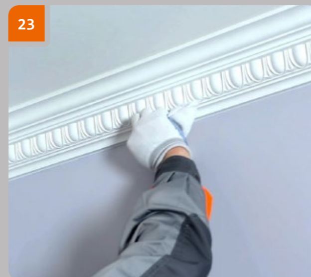
23 Удалить излишки клея тканью, смоченной водой — при использовании клея «Европласт Монтажный», ацетоном — при использовании клея «Европласт Универсальный».
