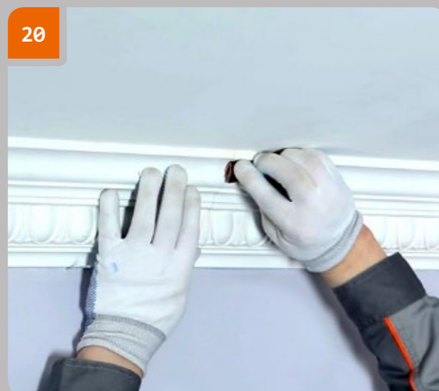
20 Спустя 3 часа мелкозернистой наждачной бумагой обработать стыки.
