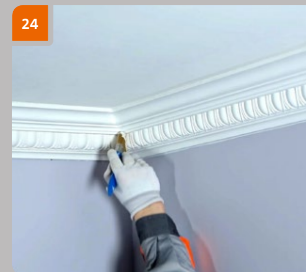
24 Следуя инструкции производителя краски, произвести окраску изделий, начиная от угла помещения.
