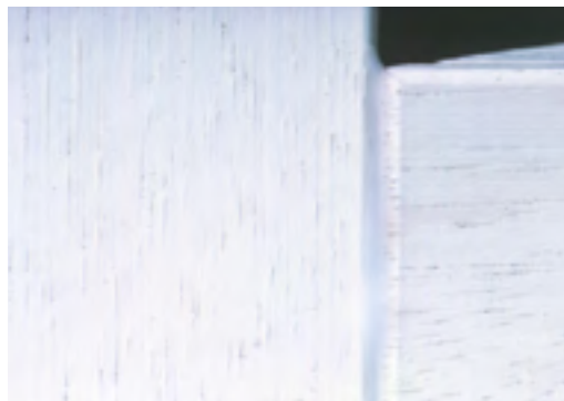
Применение герметика делает V-образное соединение водонепроницаемым
