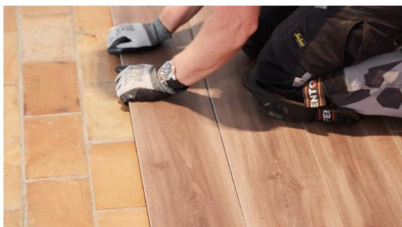
Для укладки последнего ряда панели приходится сужать. Это делается следующим образом: положите панель поверх предыдущего ряда пазом к стене, положите еще одну панель лицевой стороной вниз, прислонив ее к стене, и сделайте пометки на нижней панели. Разрежьте панели, срезав их до нужного размера, и уложите таким образом последний ряд.
