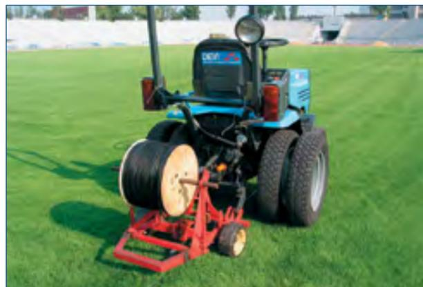
Расстояние между нитками кабеля зависит от его погонной мощности и установленной мощности на 1 м<sup>2</sup>. Эта величина лежит в пределах 20 - 40 см. Поверхность грунта практически не повреждается и готова к использованию спустя 10 - 15 дней после установки. Нагревательные кабели устанавливают на 20 - 30 см ниже поверхности, чтобы избежать их повреждения при использовании спортивных снарядов с острыми наконечниками и прочими инструментами технических служб.
