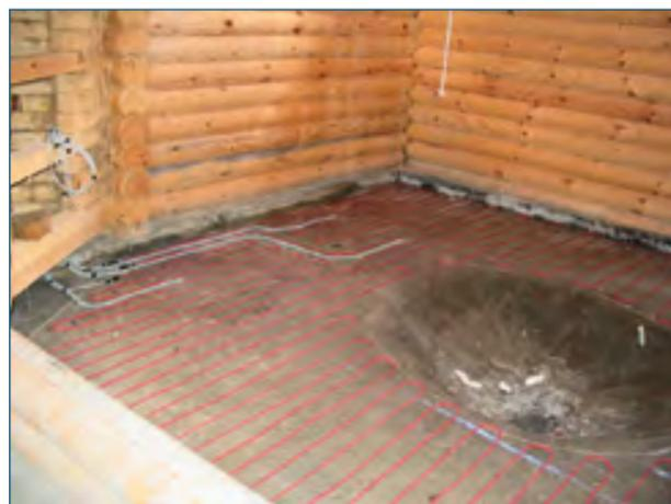
В свинарниках допустима более высокая мощность (150–200 Вт/м<sup>2</sup>) в загонах, где содержатся поросята, и пониженная – в остальной части помещения.
