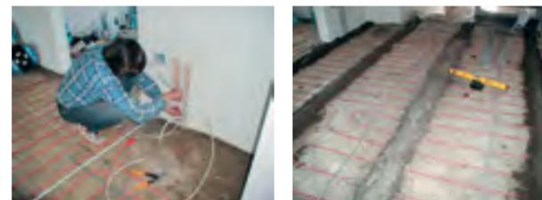
Трубка термодатчика (Ø 9 - 16 мм) должна быть заглушена со стороны датчика для предотвращения попадания внутрь раствора при заливке стяжки. Противоположный конец трубки выводят в монтажную коробку, в которой затем будет смонтирован терморегулятор. Чтобы обеспечить свободное перемещение термодатчика в трубке (возможность замены в процессе эксплуатации), рекомендуем при переходе от стены к полу выполнять два больших радиуса изгиба трубки в двух плоскостях.
