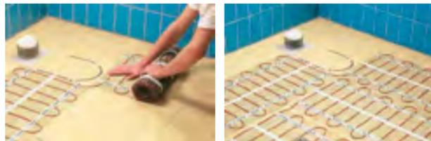
На разложенный **Devimat™** наносят плиточный клей (плиточную мастику) и укладывают плитку.
