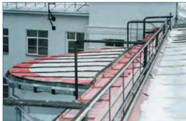
Если настенный желоб далеко отходит от края крыши, возникает опасность обледенения этого края. В этом случае рекомендуем установить 1 - 2 линии нагревательного кабеля по линии срыва воды с края крыши (так называемый капельник).
