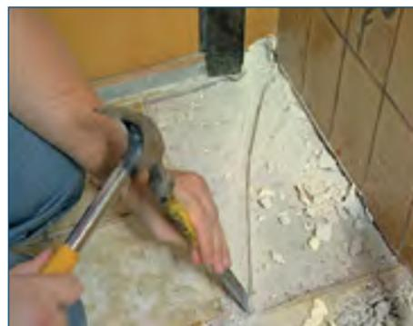
2. Штробление стяжки допускается на глубину не более 10 мм с последующим обязательным заполнением оставшихся пустот плиточной мастикой.
