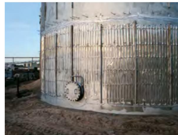
Нагревательный кабель должен быть равномерно уложен на всей поверхности резервуара.
