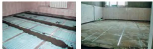
3. Разложить нагревательный кабель и закрепить на ленте с соблюдением шага укладки. Также на ленте закрепить датчик температуры пола в медной или гофрированной трубке (гофр – защита от сдавливания при заливке раствором) и подвести «холодные» выводы нагревательного кабеля и выводы датчика к месту установки терморегулятора.
