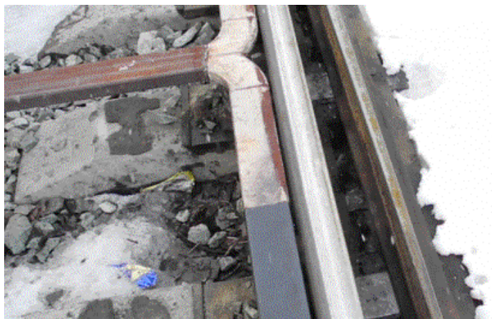
Рис. 16. Система газообогрева на стрелочном переводе.
