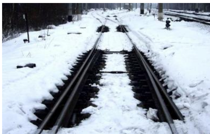
Рис. 15. Система газообогрева стрелочных переводов.
