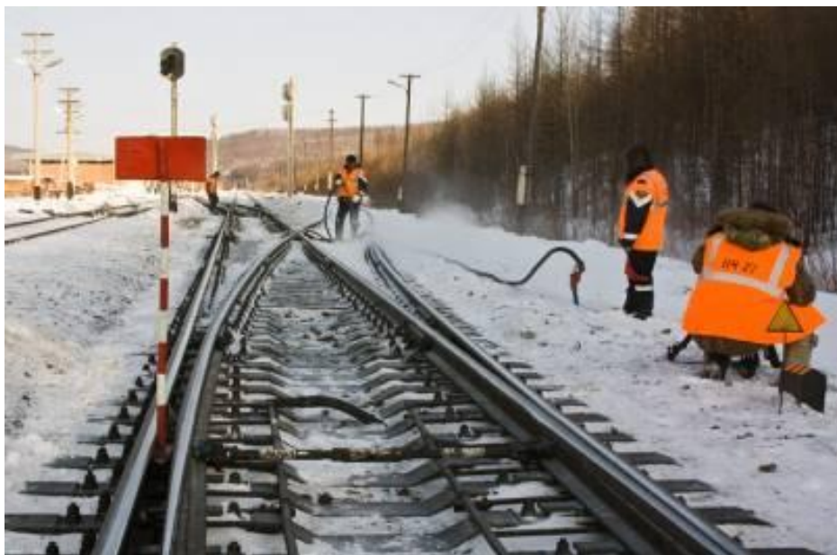
Рис. Стационарные устройства пневмоочистки стрелок от снега и устройства ручной шланговой пневмообдувки.
