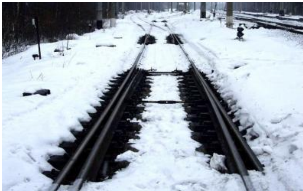
Рис. 18. Система газообогрева стрелочных переводов.
