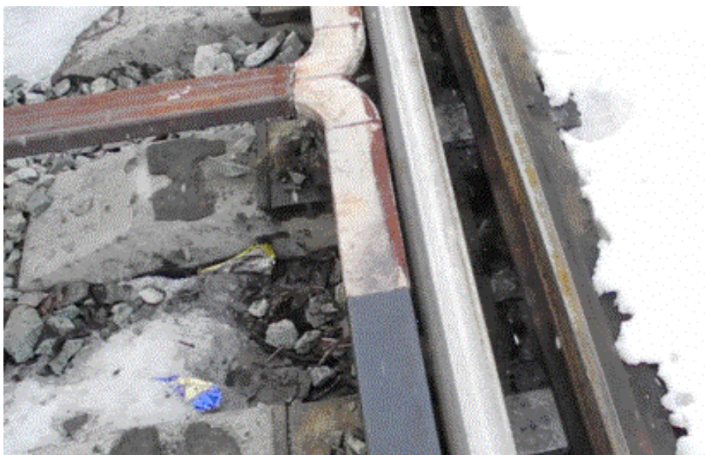
Рис. Система газообогрева на стрелочном переводе.
