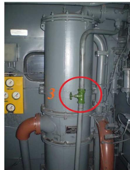
Поступает на охлаждение в радиаторные секции, а часть воды, через перепускной вентиль **3** поступает в коллектор охлажденной воды дизеля, где вода перемешивается и поступает через **ВН1** на охлаждение дизеля.
