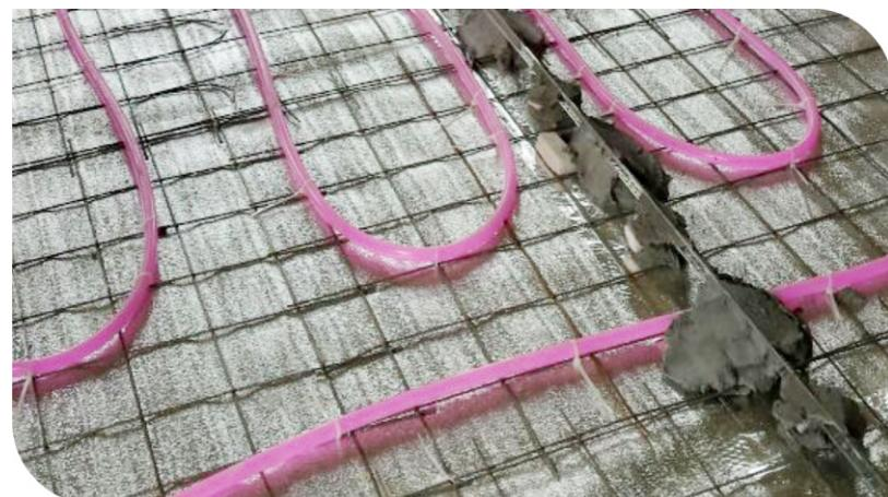
Монтаж системы «ТЕПЛОТРУБ» в доме из газобетона. Его общая площадь 210 кв.м. Уложено 18 систем «ТЕПЛОТРУБ». Каждая система подключена к программируемым терморегуляторам RTC, которые дают возможность программировать необходимые температурные режимы на каждый день недели.
