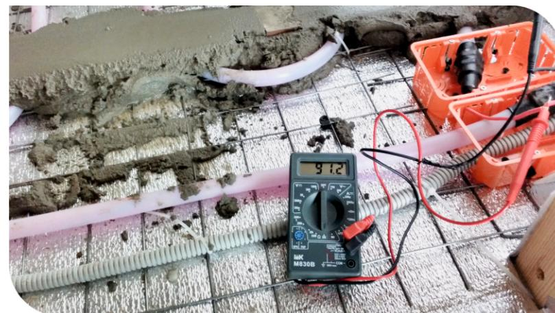
Монтаж системы «ТЕПЛОТРУБ» в двухэтажном доме, который построен по каркасной технологии. Его общая площадь 150 кв.м. Площадь укладки – 130 кв.м. Уложено 12 систем разного размера.
