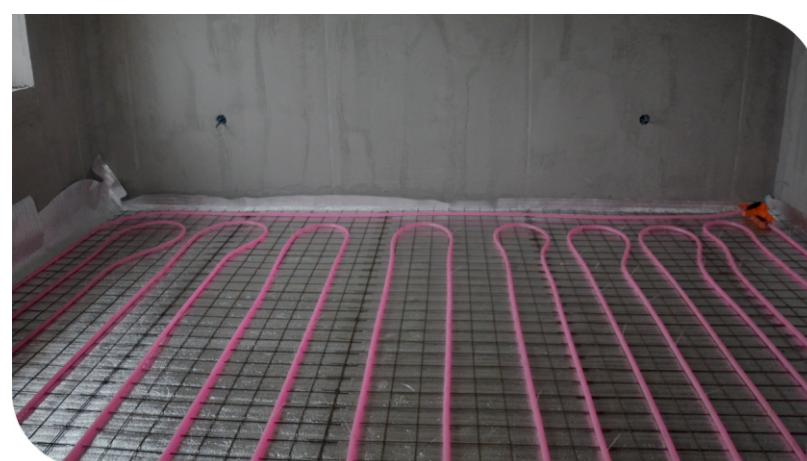
Монтаж системы «ТЕПЛОТРУБ» в двухэтажном кирпичном доме, который утеплен пенопластом и обложен облицовочным кирпичом, общей площадью 170 кв.м. Уложено 12 систем разного размера.
