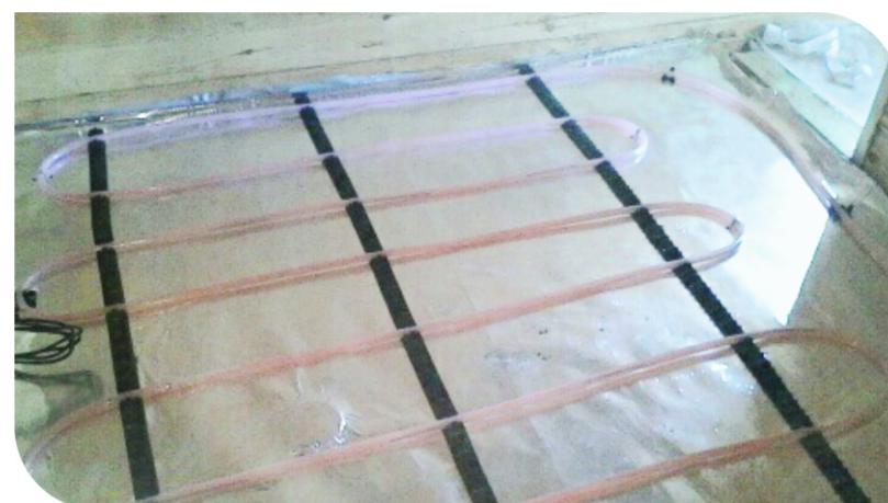
Монтаж системы «ТЕПЛОТРУБ» в двухэтажном доме, который построен из бруса. Его общая площадь 108 кв.м. Уложено 8 систем «ТЕПЛОТРУБ» не в стяжку, на пенополистирол. Применена технология «сухого» монтажа.
