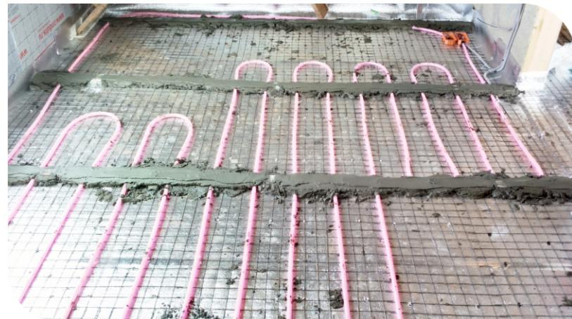
Монтаж системы «ТЕПЛОТРУБ» в двухэтажном доме, который построен по каркасной технологии. Его общая площадь 98 кв.м. Площадь укладки - 80 кв.м. Уложено 9 систем разного размера.
