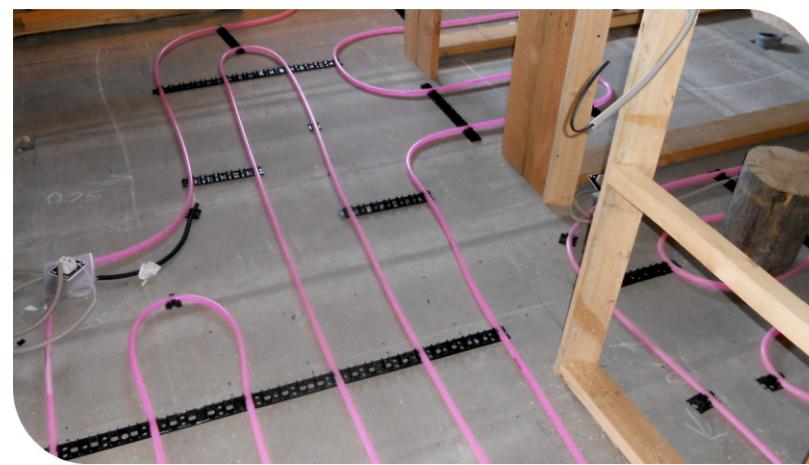
Монтаж системы «ТЕПЛОТРУБ» в двухэтажном доме, который построен из бруса. Его общая площадь 120 кв.м. Уложено 8 систем «ТЕПЛОТРУБ» не в стяжку, на пенополистирол. Применена технология «сухого» монтажа.
