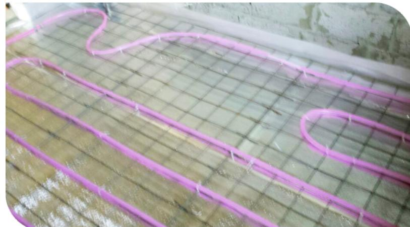
Монтаж системы «ТЕПЛОТРУБ» в доме из газобетона. Его общая площадь 175 кв.м. Уложено 15 систем «ТЕПЛОТРУБ». Каждая система подключена к программируемым терморегуляторам RTC, которые дают возможность программировать необходимые температурные режимы на каждый день недели.
