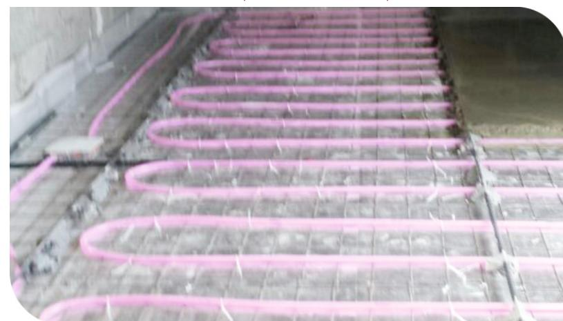
Монтаж системы «ТЕПЛОТРУБ» в доме из газобетона. Его общая площадь 110 кв.м. Уложено 9 систем «ТЕПЛОТРУБ». Каждая система подключена к программируемым терморегуляторам RTC, которые дают возможность программировать необходимые температурные режимы на каждый день недели.
