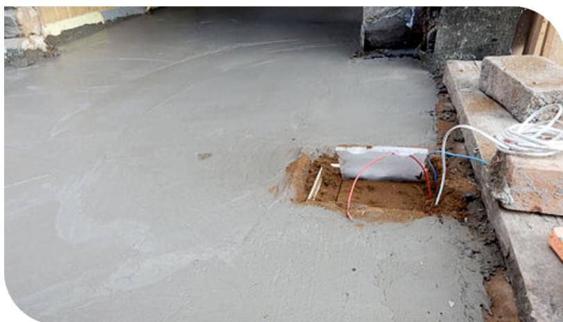
Монтаж в г. Мензелинске. Основное отопление для бани выбрана система ТеплоТруб. В качестве арматуры в чистовую стяжку использовали ферму, она же служила маяками для заливки стяжки. Главное, продумана конструкция для установки термодатчика, чтобы в случае выхода из строя можно было его поменять – это коробка с песчаной отсыпкой и подведенная к ней трубка, в которой находится провод от термодатчика.
