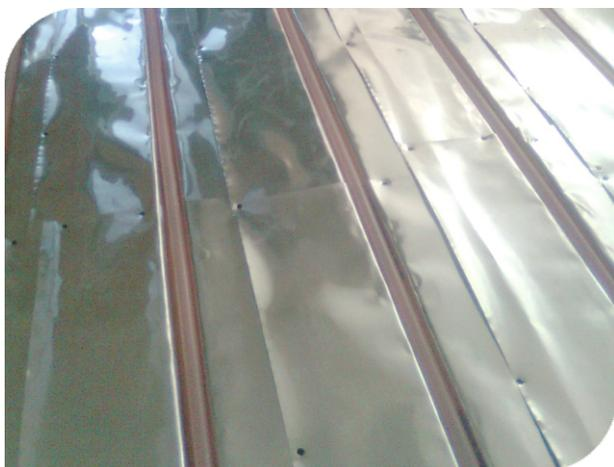
**1 вариант – пенополистирол с вырезанными пазами и теплораспределяющей фольгой.**
