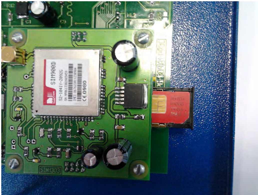
Рис.6.5. Установка лотка на место.
