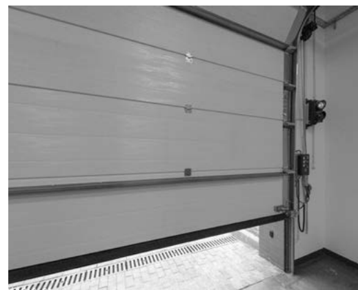
Рис. 58. Дополнительное укрепление "Omega".
