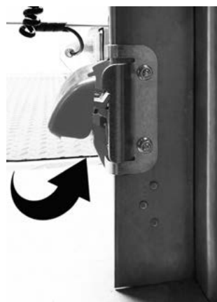
Рис. 3. Предохранение от поддевания полотна ворот.
