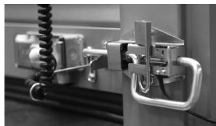
Рис. 17. Засов (ручная задвижка).
