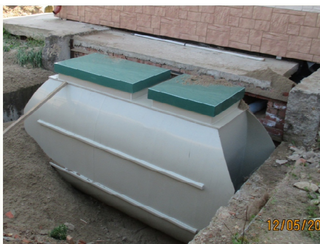
Подвод трубы справа
