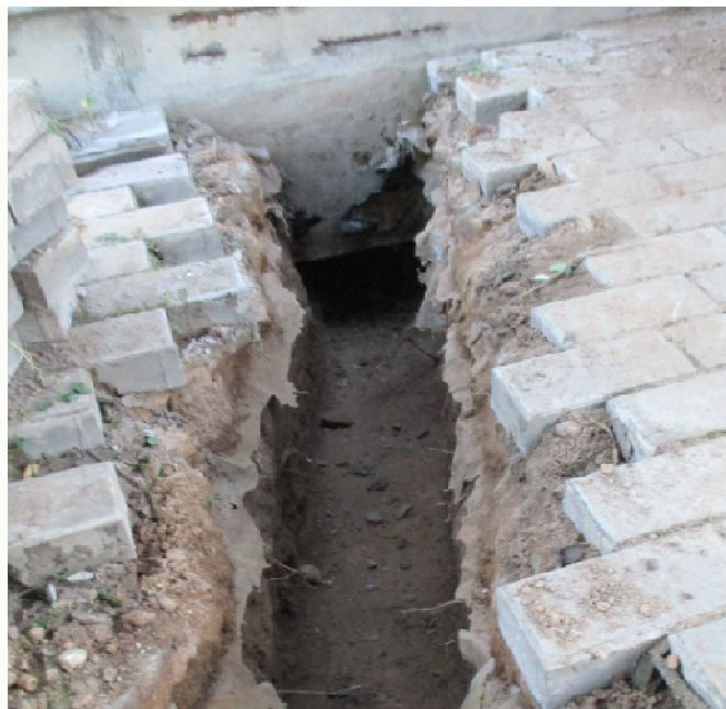
Пришлось разбирать плитку для подведения трубы канализации
