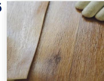
**2.** Подрезать уложенные внахлест полосы винилового покрытия для получения ровного и плотного стыка, используя длинную металлическую линейку. Удалить отрезанные полосы.
