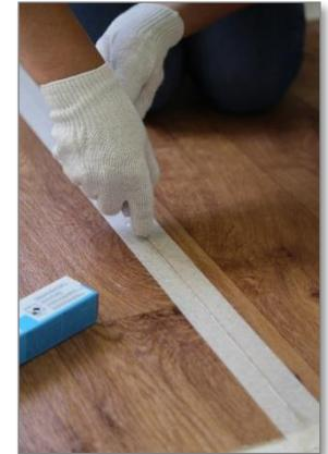
Жидкость сваривает края покрытия и таким образом образует гомогенное (однородное), плотное и прочное соединение.
