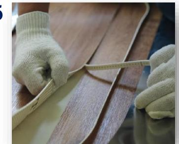
**3.** Поверх стыка по всей длине приклеить малярный скотч или ленту для предотвращения попадания жидкости для сварки на покрытие.
