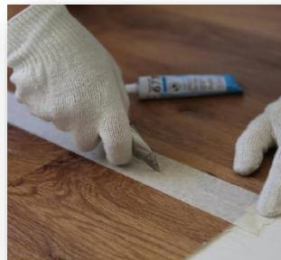
**5.** Иголку на наконечнике тюбика поместить в шов, слегка надавить на тюбик и затем плавно и равномерно передвигать иголку вдоль шва, заполняя его жидкостью.
