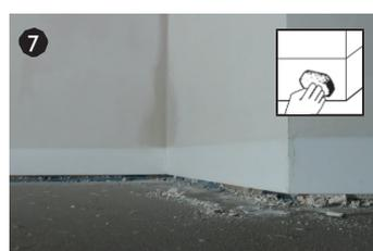
7 После оштукатуривания очистите плинтус с помощью воды и сухой ткани.
