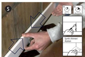
5 Сдвиньте два профиля вместе и удалите излишки клея до того, как он затвердеет (максимум 1 час и повторите через 2-3 часа). Очистите ацетоном или аналогичным растворителем.
