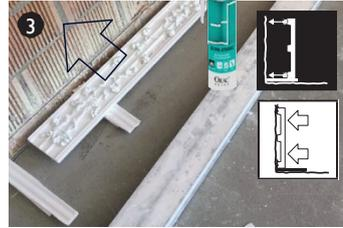
3 Прижмите плинтус с достаточным количеством клея DecoFix Power к стене. Смойте остатки клея мыльной водой и губкой в течение 10 минут.
