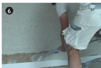
6 После затвердевания клея (через 24 часа после приклеивания) нанесите на стену штукатурку слоем толщиной, равной толщине установленного плинтуса.
