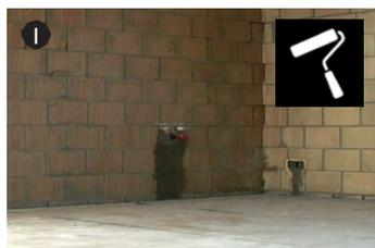
1 Перед оштукатуриванием нанесите на стену грунтовку (оптимальная обработка штукатурки + лучшее прилипание к поверхности).
