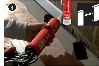
4 Обработайте стыки плинтуса клеем DecoFix Extra. Используйте достаточное количество клея DecoFix Extra по бокам уже установленного плинтуса.
