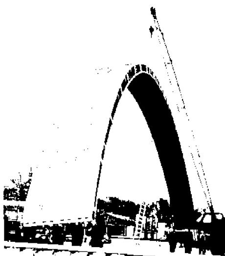
Рис.7.21. Арочные трехслойные алюминиевые конструкции пролетом 40 м (Венгрия)
