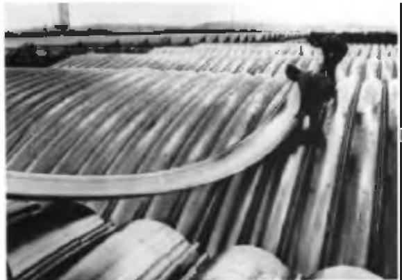
Рис.7.25. Элементы двойкой кривизны сводчатых покрытий из алюминия системы «Пара» (Австрия)
