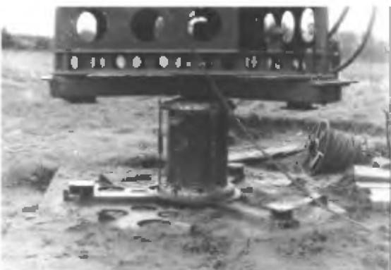
Рис.1.56. Установка ствола телескопической мачты высотой 52 метра на изолатор
