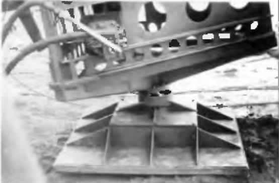
Рис.1.54. Установка ствола мачты на грунт
