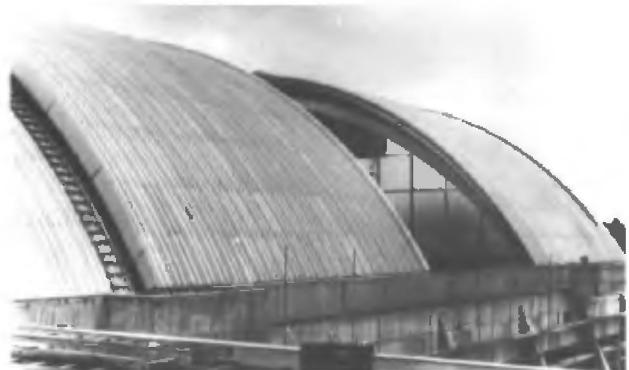
Рис.7.22. Раздвижное покрытие бассейна из арочных алюминиевых трехслойных элементов пролетом 24 м (Венгрия)
