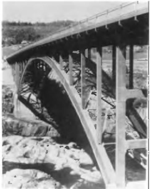
Рис.7.31. Мост из алюминиевых сплавов через р. Сегеней с русловым пролетом 88,5 м (Канада)
