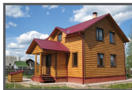
Частный дом, Россия Применение агломерата для теплоизоляции кровли, стен, межэтажных перекрытий.
