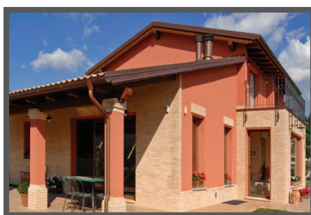
Частный дом, Италия Применение агломерата для теплоизоляции кровли, межэтажных перекрытий, полов.
