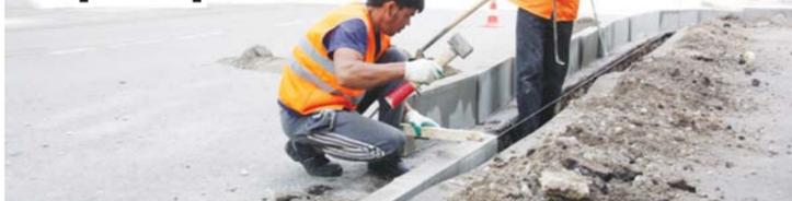
В Люберцах продолжается ремонт автомобильных дорог, внутриквартальных проездов и тротуаров. Уже полным ходом в городе идут работы по установке нового бордюрного камня. Впереди – капитальный ремонт и асфальтирование проезжей части.
