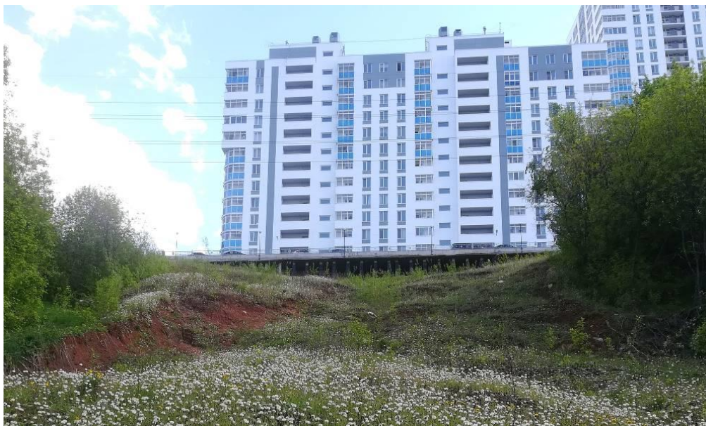
Рис. 7. Валы и внутренний уступ оползня в 2020 г. (фото автора)
