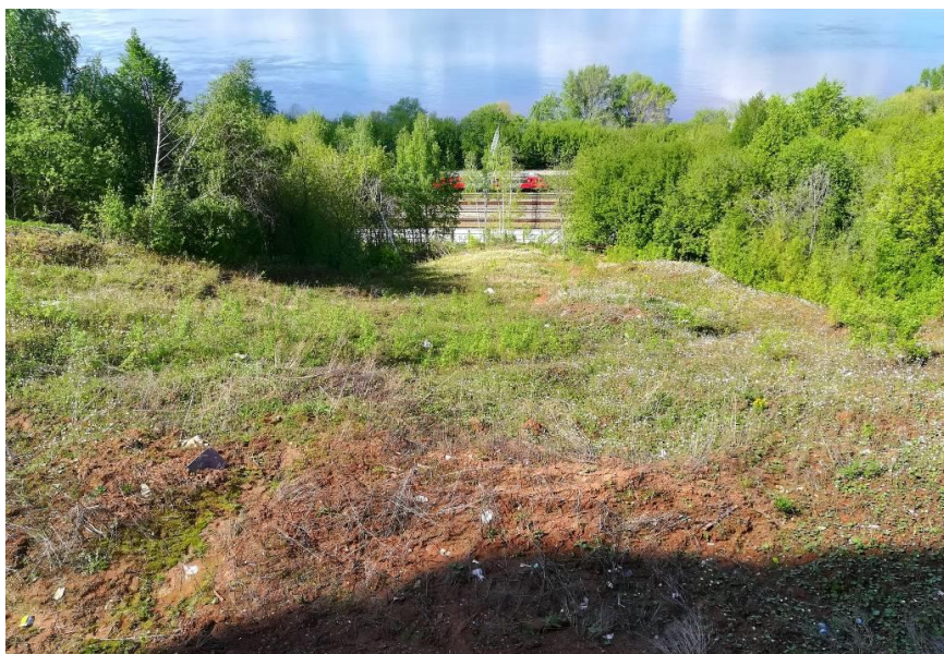
Рис. 3. Склон оползня в 2020 году (фото автора).
