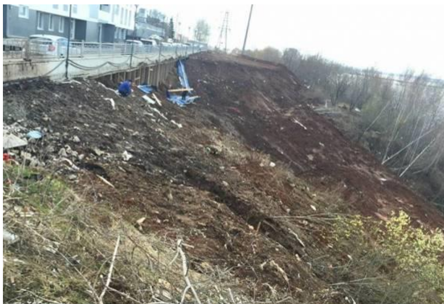
Рис. 2. Склон оползня в 2016 году [1]
