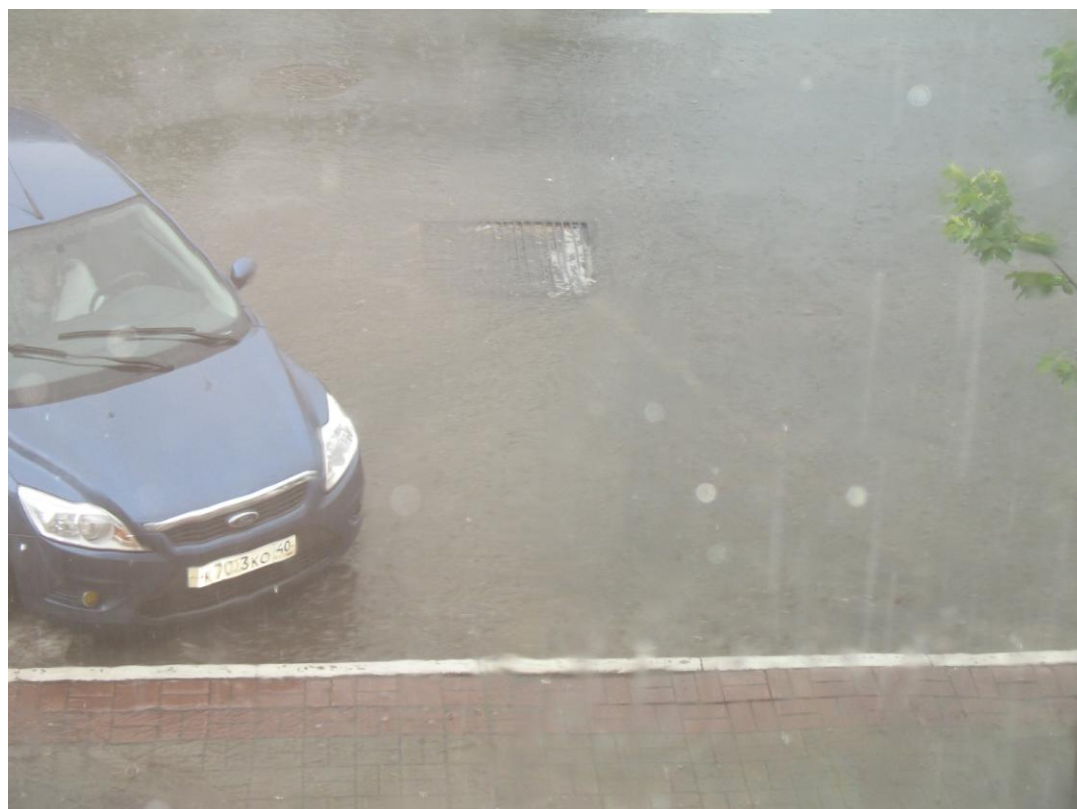
Рис. 2. Люк ливневой канализации не справляется с поступающей дождевой водой
