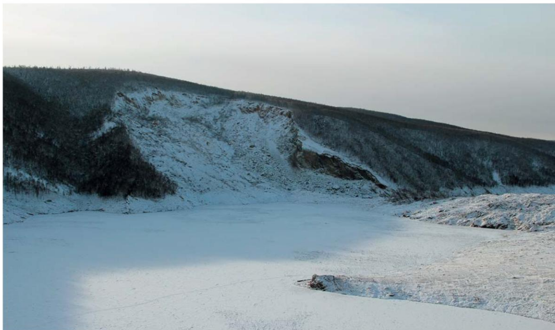
Рис. 1. Грунтовая плотина (в центре снимка и справа), перегородившая Бурейское вдхр (передний план) путём катастрофического смещения грунтовых масс с левого борта долины р. Бурея. Стенка их срыва – на среднем плане левее плотины. Фото Е.Потворовой [3, с.14]
