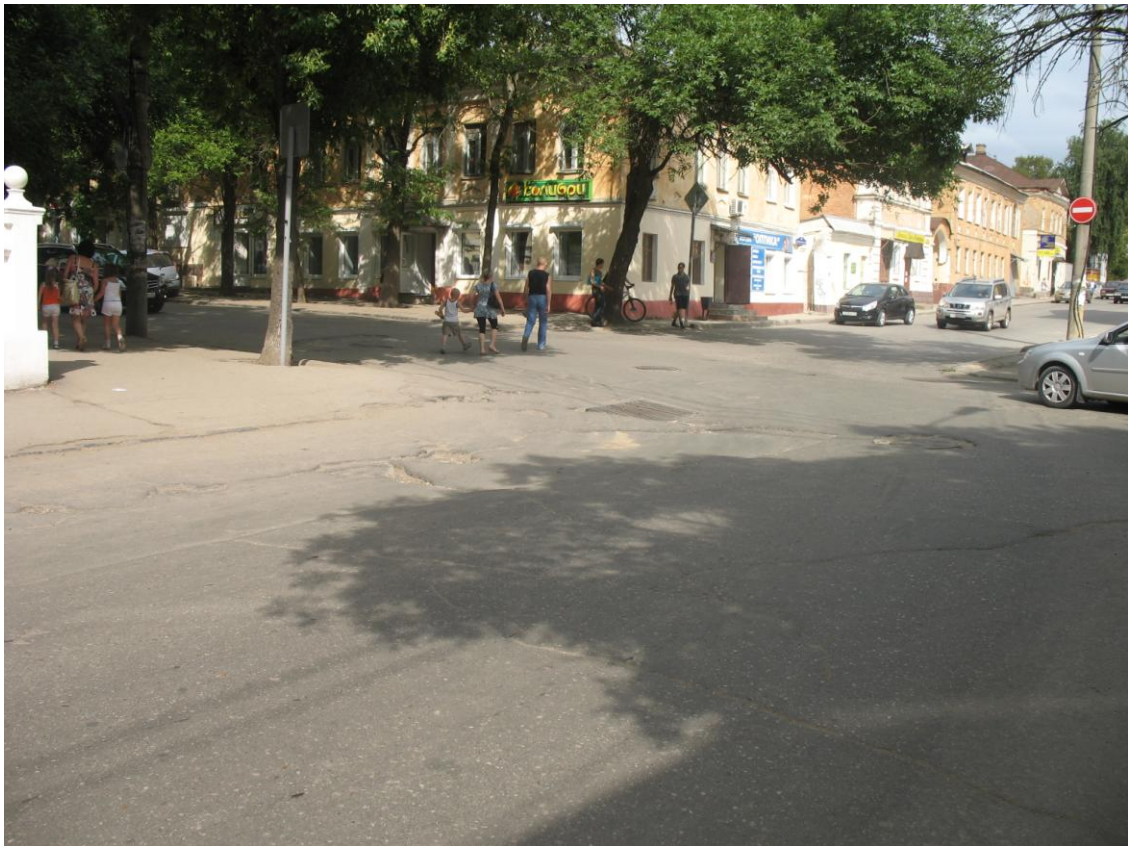
Рис.3. Люк ливневой канализации в стороне от тальвега уличного ливневого временного водотока
