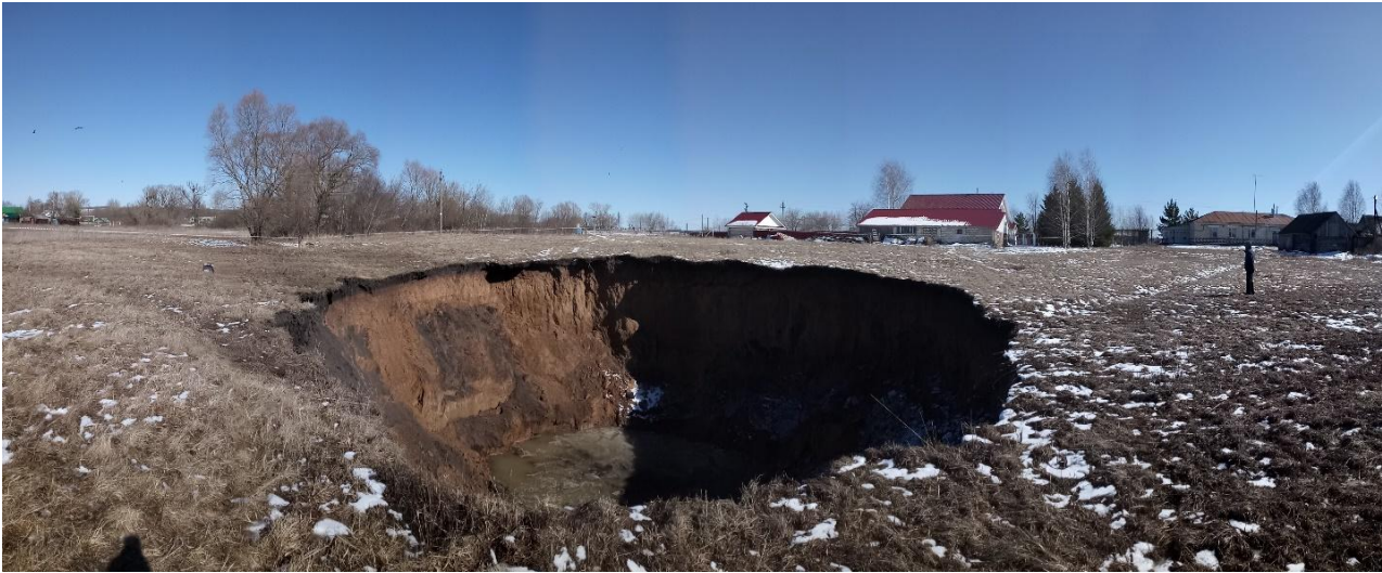
Рис. 1. Общий вид карстового провала 25.03.2020 г. Вид с западной стороны
