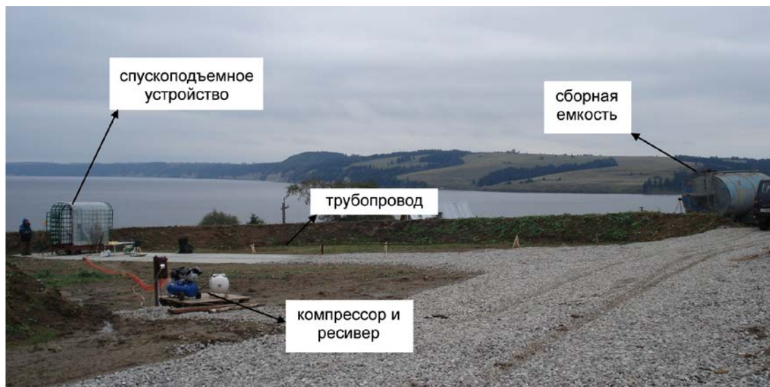
Рис. 2. Насосное оборудование, при помощи которого была произведена откачка нефтепродуктов
