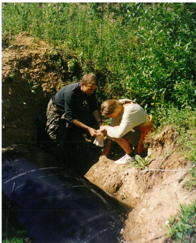
Рис. 3. Обнажение трубы магистрального газопровода в карстовой воронке
