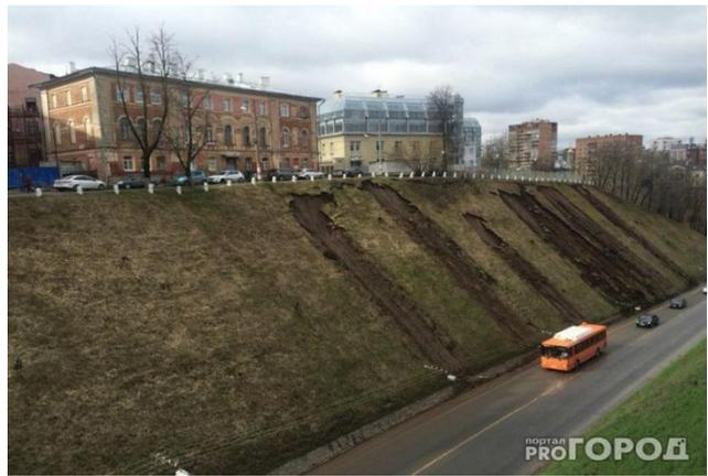
Рис. 7. Оползни в апреле 2016 года на спуске к Метромосту (слева) и на Зеленском съезде (справа)
