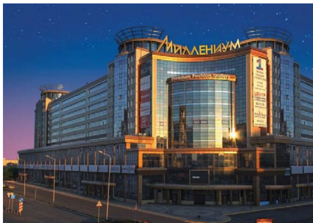
ТОРГОВЫЙ ЦЕНТР «МИЛЛЕНИУМ» Омск, 410 кВт
