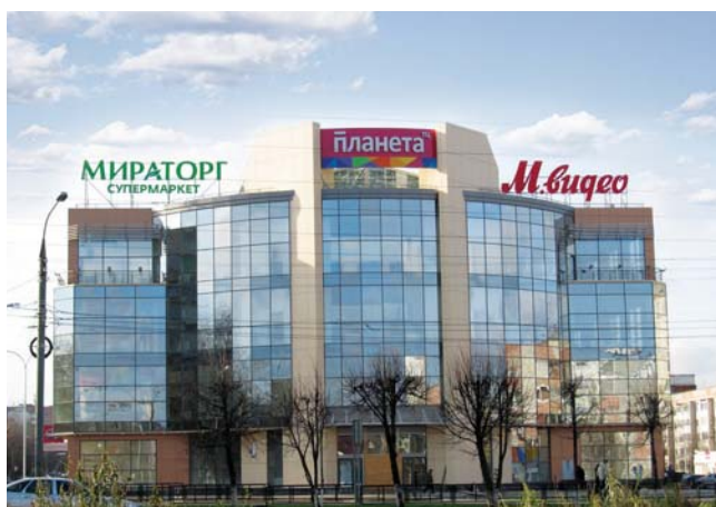
ТОРГОВЫЙ ЦЕНТР «ПЛАНЕТА» Йошкар-Ола, 836 кВт
