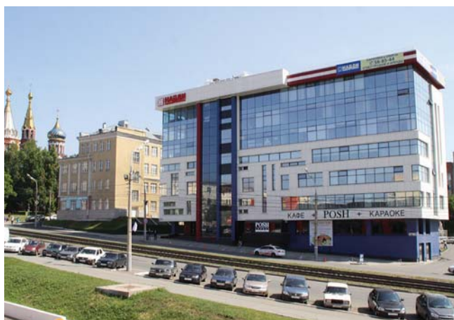
БИЗНЕС-ЦЕНТР «НАЙДИ» Ижевск, 498 кВт
