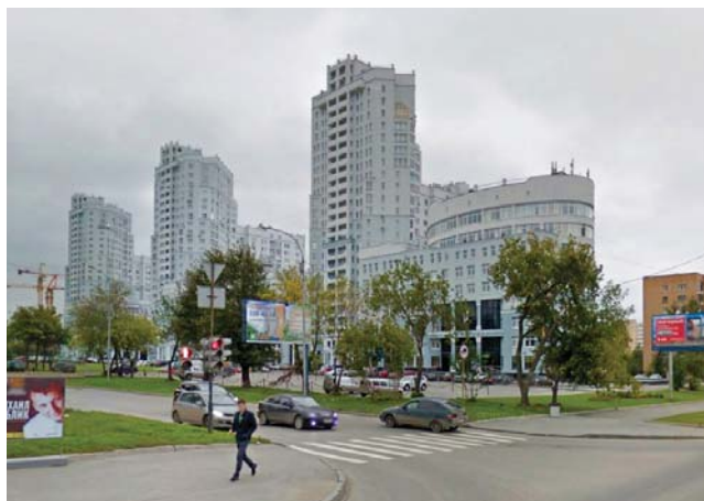
БИЗНЕС-ЦЕНТР «ТАТИЩЕВСКИЙ» Екатеринбург, 500 кВт
