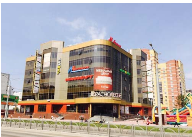
ТОРГОВЫЙ ЦЕНТР «КРАСНОЛЕСЬЕ» Екатеринбург, 700 кВт
