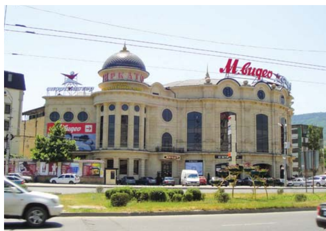
ТОРГОВЫЙ ЦЕНТР «МИРКАТО» Махачкала, 590 кВт
