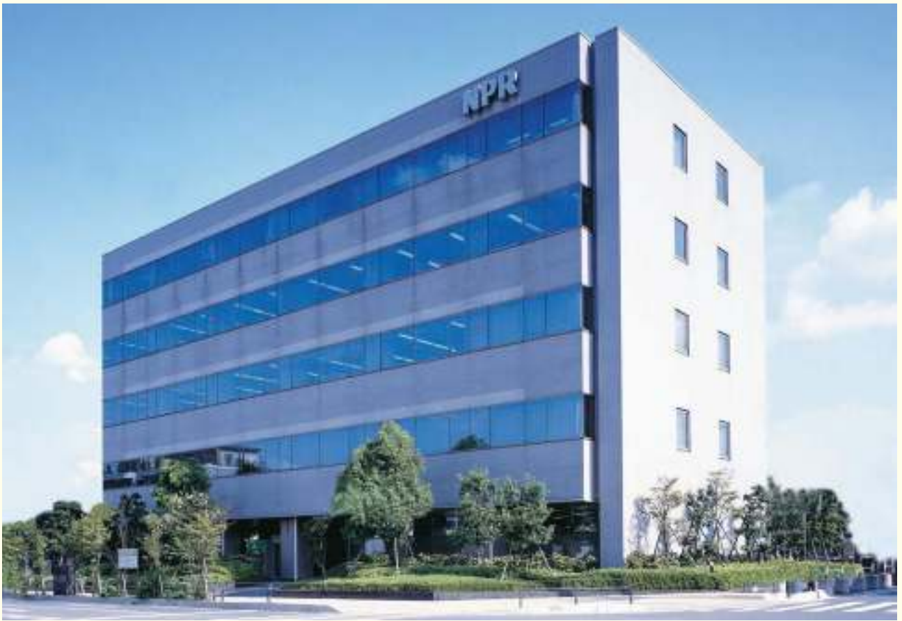
▲Head Office 本社
