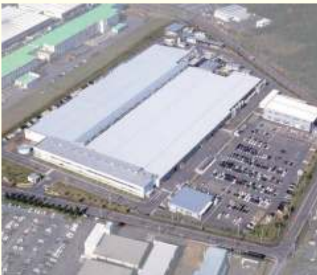
▲NPR Iwate Co.,Ltd./Ichinoseki Plant (株)日ビス岩手/一関工場
