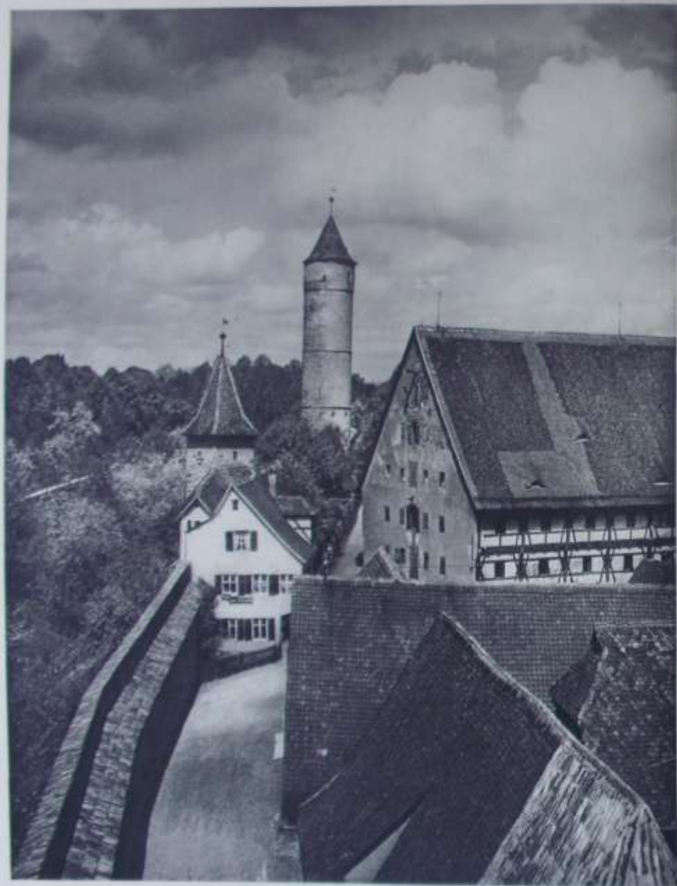
Die Stadtmauer in Dinkelsbühl Dinkelsbühl. L'enceinte de la ville
