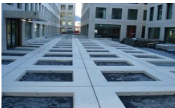
Устройство дренируемого дорожного покрытия в городском ландшафте
