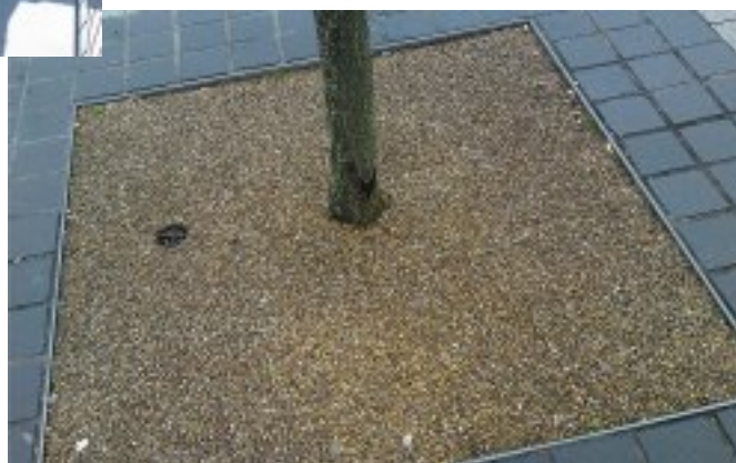
Устройство дренируемого дорожного покрытия в городском ландшафте
