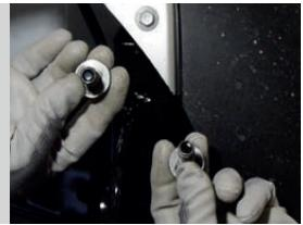
**ШАГ 3.** Для установки центрального кронштейна совместите отверстия в кронштейне с отверстиями в боковых кронштейнах и соедините болтами M10x40, гайками M10 через гроверные шайбы M10 и шайбы M10.
