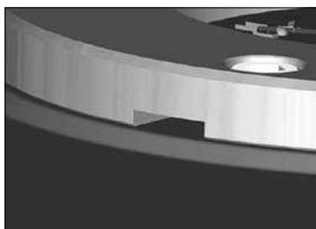
**КАНАВКА НА КРЫШКЕ СМОТРОВОГО СТЕКЛА ДЛЯ СЛИВА ДОЖДЕВОЙ ВОДЫ**
