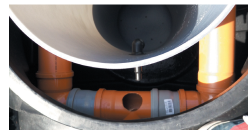
рисунок 2 Переливная система в стакане биофильтра «Rostok» Плюс
