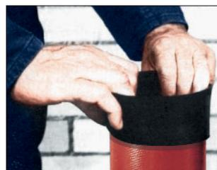
1. Сначала на нижний край трубы надевается уплотнительная манжета, а именно так, чтобы внутреннее распорное кольцо равномерно легло на срез трубы.
