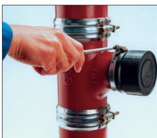
1. Сначала манжету KONFIX с ослабленной натяжной лентой до упора надвинуть на трубу PAM-GLOBAL®, затем при помощи натяжной ленты закрепить на трубе.
