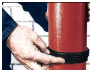
3. Следующую трубу или фасонную часть плотно насадить на распорное кольцо, и вывернутую половину манжеты развернуть назад.
