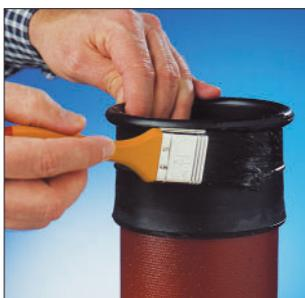
2. На верхнюю половину соединительного элемента Rollfix наносится смазка (разбавленный мыльный смазочный раствор).
